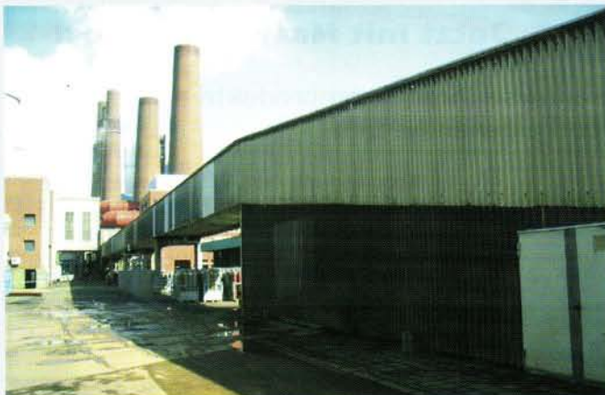
Abb. 1 Um den Aschen-Transport im Kraftwerk Niederaußem kümmert sich seit Sommer 2003 die SAG Netz- und Energietechnik
