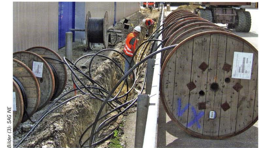
Bis zum Einspeisepunkt mussten 3,5 km Kabel in Gräben verlegt werden.
