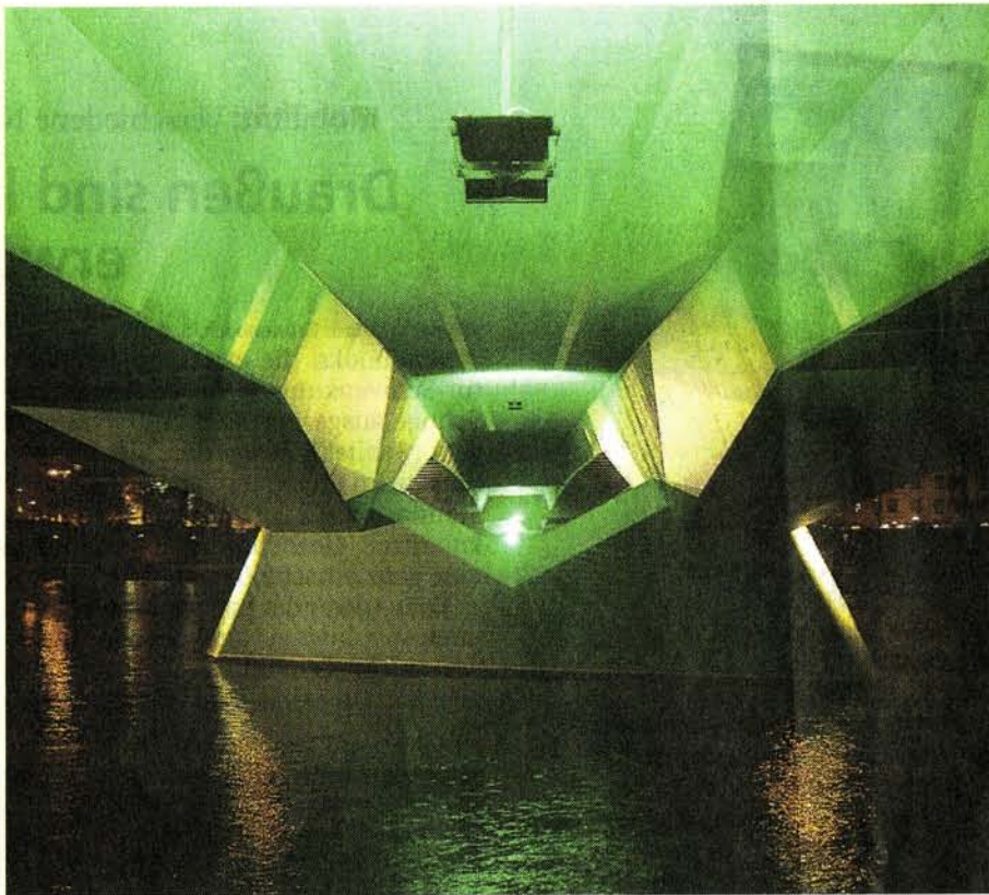
Bei der Stadtraum-Illumination in Frankfurt/M. sollen Brücken und Kaimauern aus sich selbst heraus leuchten und die Lichtquellen möglichst nicht sichtbar sein. Foto: SAG
